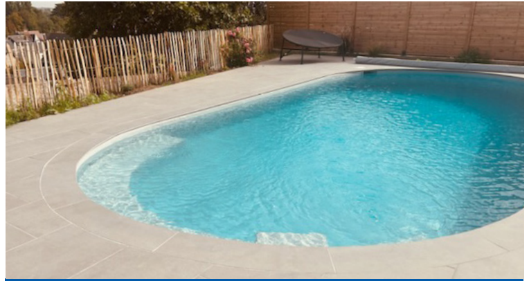
Rénovation terrasse + revêtement.
